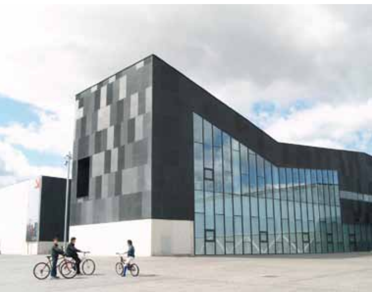
Fachada ventilada resuelta con placas de hormigón polímero
