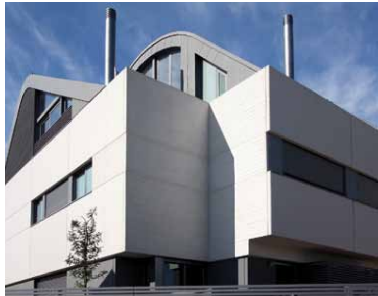
Fachada de hormigón sin tratamiento fabricado en molde de caucho
